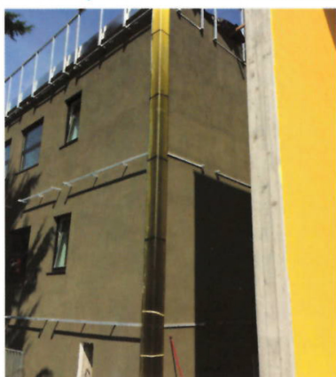
L'involucro esterno. Creazione della "seconda pelle" mediante installazione di fasce di materiale traslucido (polycarbonato alveolare), nelle tonalità gialle e grigie, su prospetti differenti
