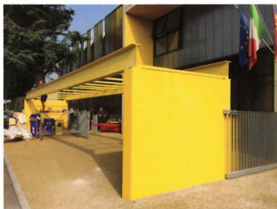
Sistemazione degli esterni fronte strada e dell'ingresso principale mediante inserimento della pensilina in struttura metallica. La tettoia gialla segna l'ingresso alla scuola
